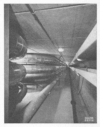
Fig. 6. — Caniveau à tuyauteries souterrain de  $2,5\times2,5$  m. Le côté gauche est occupé par des tuyauteries pour tous usages; la paroi de droite porte les câbles électriques dans des rigoles en fibrociment. Les gros tuyaux avec revêtement de tôle contiennent les conduites calorifugées amenant à la fonderie, sous forme d'eau surchauffée, la chaleur fournie par la centrale thermique.
