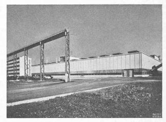
La fonderie vue du sud-ouest. Au-dessus du toit, les lanterneaux à fenêtres verticales ; au milieu, la superstructure pour le conditionnement d'air; à gauche, le bâtiment à cinq étages pour les bureaux.
