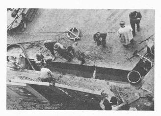
Fig. 7. — Paroi en fouille constituant l'enceinte d'une excavation pour passage sous chaussée à Lucerne.
