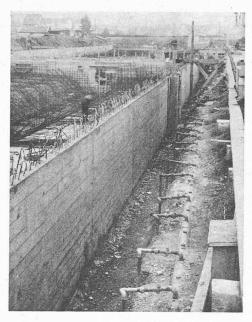
Fig. 8. — Rabattement de la nappe à l'aide du procédé Well-Point (EMPA, Dübendorf. Surface 183 × 25 m; 290 puits de 6 m, rabattement de la nappe de 3,3 à 4,2 m; profondeur max. de la fouille 3,3 m. Installation de deux pompes de 8"; débits observés: max. 2000 l/min au début; resp. 600 l/min en régime permanent).
