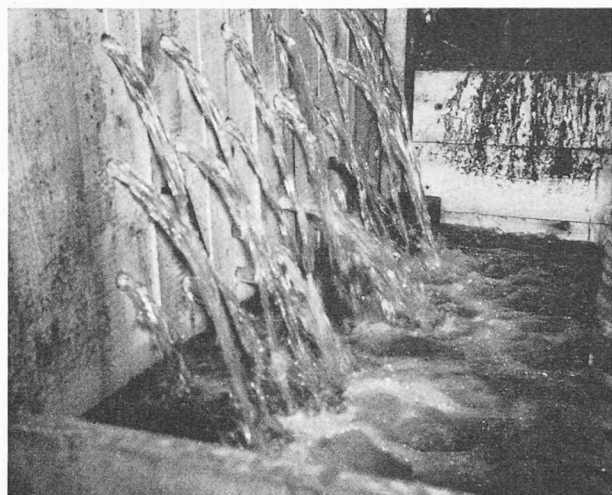
Fig. I/6. — Irruption d'eau lors du fonçage du puits de montage du bouclier.
