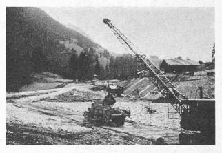
Fig. 25. — Travaux d'excavation au fond du bassin sur chaussée provisoire.
