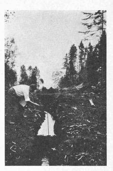
Fig. 31. — Une tranchée dans la tourbe de 2 à 2,5 m de hauteur tient verticalement.
