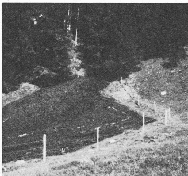
Fig. 30. — Glissement de la décharge : la tourbe dévale comme un liquide dans le Steinibach en direction de la Simme.
