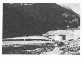
Fig. 36. — Tour de prise et construction du by-pass en tuyaux métalliques à soufflets posés sur la tourbe.
