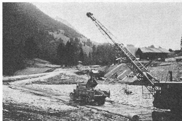
Fig. 25. — Travaux d'excavation au fond du bassin sur chaussée provisoire.
