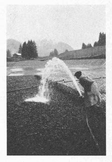
Fig. 37. — Protection des berges avec pénétration au bitume 10 kg/m², types AG, figure 38.
