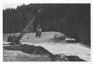
Fig. 21. — S.K.W.: Dragueline « Skoda-Menck » de 44 t sur chenille sur chaussée provisoire et matelas de madrier.
