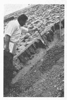
Fig. 27. — S.K.W.: Perré de protection sur rive nord incliné à 4:5 avec souscouche en mortier poreux destiné à prévenir l'érosion interne.
