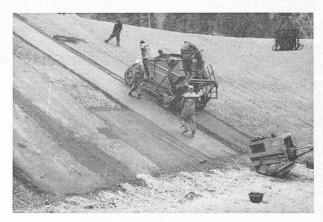
Fig. 17. — Pose de la première couche de 4 cm du tapis étanche suivant la ligne de pente.
