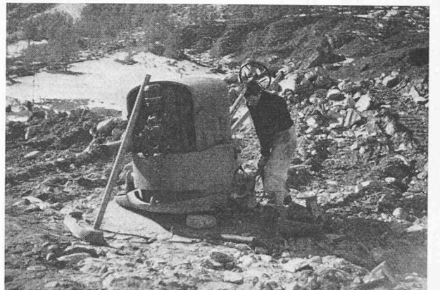
Fig. 8. — Vibreur « Vibromax » — Démontage des plaques latérales pour réduire la surface d'action.
