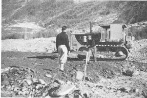
Fig. 5. — Mise en place d'une couche de 40 cm au moyen du bulldozer. La teinte plus foncée des matériaux remués dénote une humidité naturelle du matériau. Des blocs jusqu'à environ 40-50 cm de Ø sont compris dans le matériau répandu.
