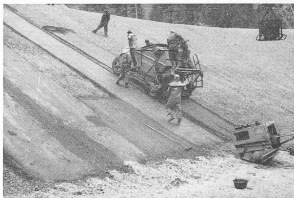
Fig. 17. — Pose de la première couche de 4 cm du tapis étanche suivant la ligne de pente.
