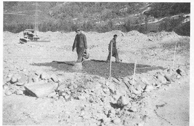
Fig. 6. — Arrosage d'un champ délimité par quatre piquets : épaisseur de la couche avant compactage 40 cm environ. Eau répandue en une fois. Au fond, le bulldozer au travail.
