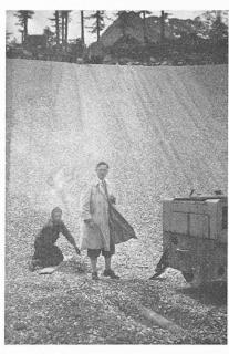
Fig. 16. — Essais de compactage, au rouleau vibrant Dingler de 2,2 t sur gravier 17-35 mm. Le drain  $\varnothing$  10 cm sous-jacent résiste sans se casser.
