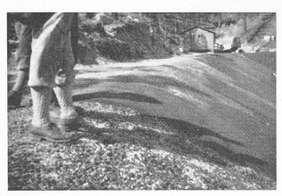
Fig. 15. — Exécution de la sous-couche en gravier 17-35 avec pénétration de 2 kg/m² de bitume. Au second plan, pose de la première couche du tapis bitumineux.
