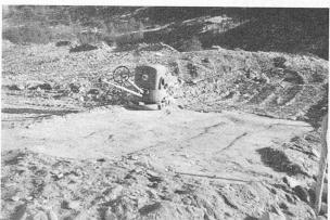
Fig. 7. — La plaque vibrante « Vibromax » at. 5000 : vibration à sec, deux passes. Au fond, le terrain labouré par les chenilles du bulldozer. Au 1er plan, le terrain donne une idée de la composition granulométrique.
