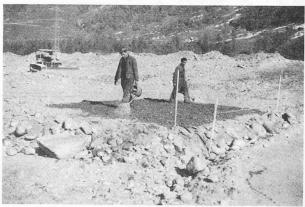
Fig. 6. — Arrosage d'un champ délimité par quatre piquets : épaisseur de la couche avant compactage 40 cm environ. Eau répandue en une fois. Au fond, le bulldozer au travail.
