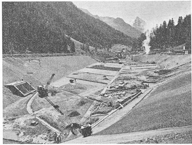
Fig. 15. — Vue générale du bassin, état des travaux, été 1957.
