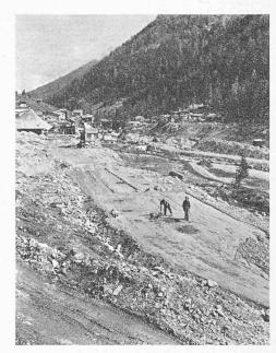
Fig. 11. — Pistes d'essais pour les travaux de remblayage des digues.
