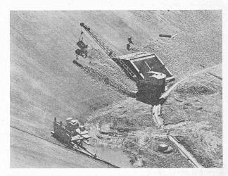
Fig. 16. — Mise en place de la couche drainante Ø 30 à 60 mm. Au centre, entrée de la galerie Motec-Vissoie.
