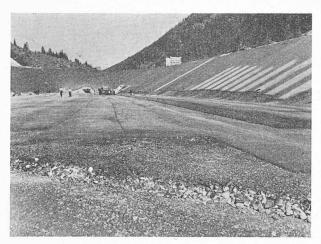
Fig. 17. — Détail du revêtement couche filtrante, couche drainante et revêtement bitumineux.
