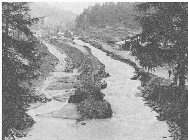
Fig. 12. — Vue du chantier, août 1956. (Photo Brügger, Zurich)
