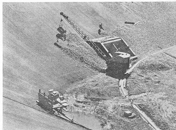
Fig. 16. — Mise en place de la couche drainante Ø 30 à 60 mm. Au centre, entrée de la galerie Motec-Vissoie.
