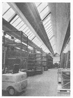
Fig. 6. — Voile mince plissé précontraint de  $36~\mathrm{m}$  de portée (Siemens-Zurich).
