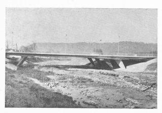
Fig. 7. — Pont biais précontraint avec appuis triangulés sur la Sihl à Zurich (Brunau).
