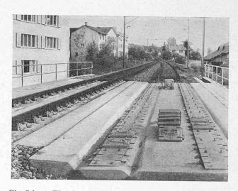
Fig. 5 b. — Fixation des rails sur le béton.
