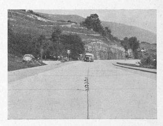
Fig. 11. — Raccordement entre les courbes de rayons 600 m et 500 m, point d'inflexion.
