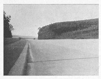
Fig. 13. — Raccordements entre les courbes de rayons 600 m et 500 m. Point d'inflexion
