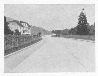
Fig. 8. — Raccords verticaux
