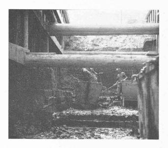
Fig. 5. — Exécution de la fouille entre rideaux de palplanches. Point 3 de la méthode d'exécution (voir chapitre III).
