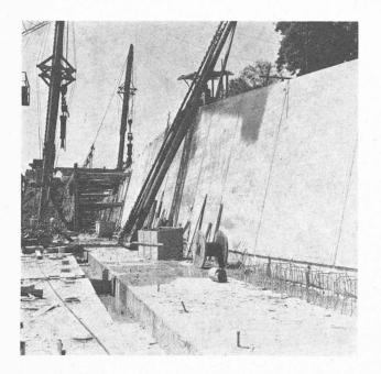
Fig. 7. --- Mur, semelle et bêche de butée. Au fond, arrachage du rideau de palplanches aval.
