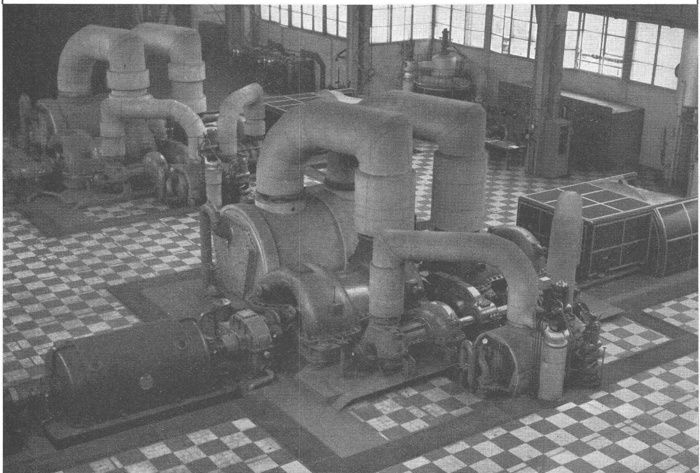
Vue des deux turbines à gaz de 7500 kW de la Société Métallurgique Hainaut-Sambre à Couillet, Belgique. Ces groupes, qui utilisent comme combustible du gaz de haut-fourneau, sont en exploitation permanente et totalisent ensemble plus de 25 000 h de marche.
