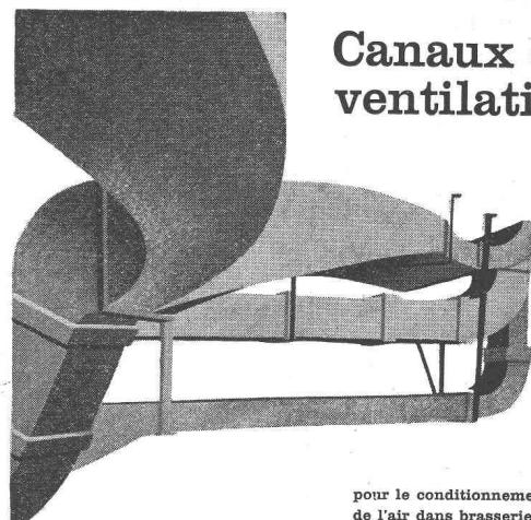
pour le conditionnement de l'air dans brasseries, abattoirs, halles industrielles, dépôts de denrées alimentaires, bureaux, restaurants. Durables et résistants, ils ne rouillent pas. Grâce aux parois très lisses, minime frottement de l'air. Exécution de pièces spéciales selon plans.
