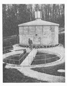
Fig. 2. — Epuration biologique : Filtre biologique ouvert ; Décanteur final.
