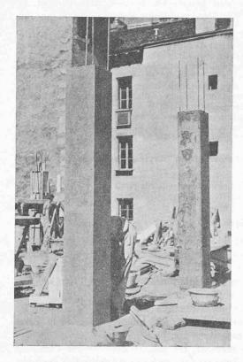
Fig. 12. — Poteaux traités au Vacuum Concrete.
