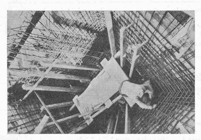
Fig. 3. — Armature d'une trémie de silo.
