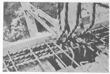
Fig. 1. - Nœud d'armatures avec barres en attente.
