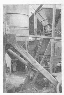
Fig. 10. - Bétonnière automatique et son silo à ciment.
