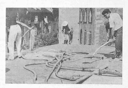
Fig. 11. — Traitement d'une dalle par le vide (Vacuum Concrete).
