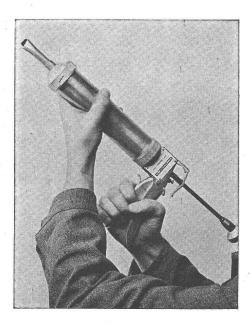
Pour rendre étanches : joints de dilatation, joints entre éléments de construction préfabriqués, recouvrements d'Eternit ondulé et tôles de toitures, manchons de tuyaux de descentes.
