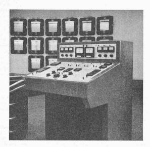
Fig. 5. — Pupitre de réglage installé au dispatching de la C.P.T.E. à Bruxelles.
