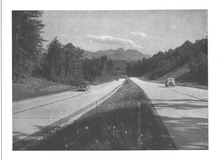
L'Allemagne possédait quelques milliers de kilomètres d'autoroutes bétonnées, il y a une vingtaine d'années. Malgré certains défauts qui se sont révélés sous un trafic extrêmement lourd et dense et auxquels on a remédié depuis, le revêtement en béton conserve la faveur des constructeurs, puisque chaque année, il s'en construit plusieurs dizaines de kilomètres, notamment sur l'autoroute de Karlsruhe, en direction sud, qui s'approche de Bâle à grands pas.
