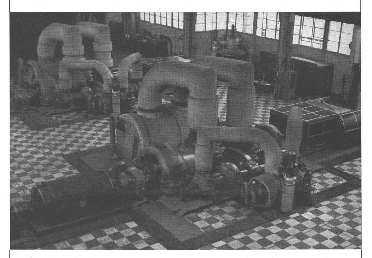
Vue des deux turbines à gaz de 7500 kW de la Société Métallurgique Hainaut-Sambre à Couillet, Belgique. Ces groupes, qui utilisent comme combustible du gaz de hautfourneau, sont en exploitation permanente et totalisent ensemble plus de 25 000 h de marche.
