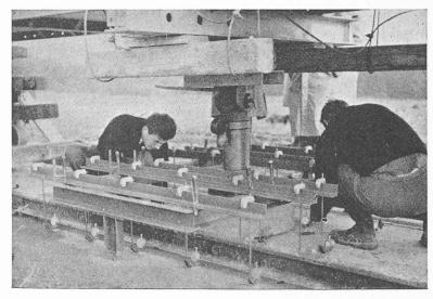
Fig. 14 et 15. — Essais de charge de la dalle, avec la plaque de répartition de 75 cm de diamètre.
