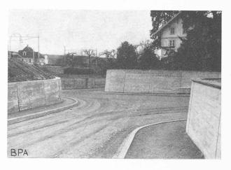
Fig. 2. — Ces hauts murs à proximité d'un passage sousvoies empêchent la visibilité d'une route à l'autre. Les inconvénients et dangers momentanés du passage à niveau ont été éliminés, mais un risque permanent de collisions est apparu.
