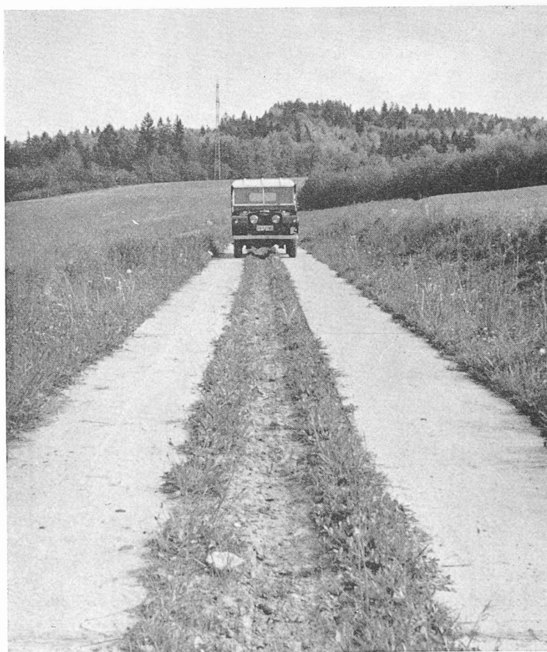
Fig. 10. — Chaussée à double bande de roulement, en béton.
