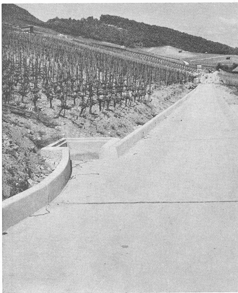
Fig. 6. — Vignoble de La Côte. Route en béton. Dalle 2,80 m de largeur pour la circulation et l'écoulement des eaux de surface.
