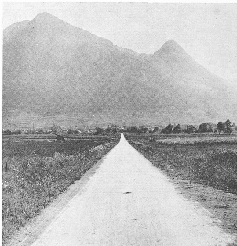
Fig. 2. — Plaine du Rhône : chaussée de béton, largeur de la dalle 2,80 m.
