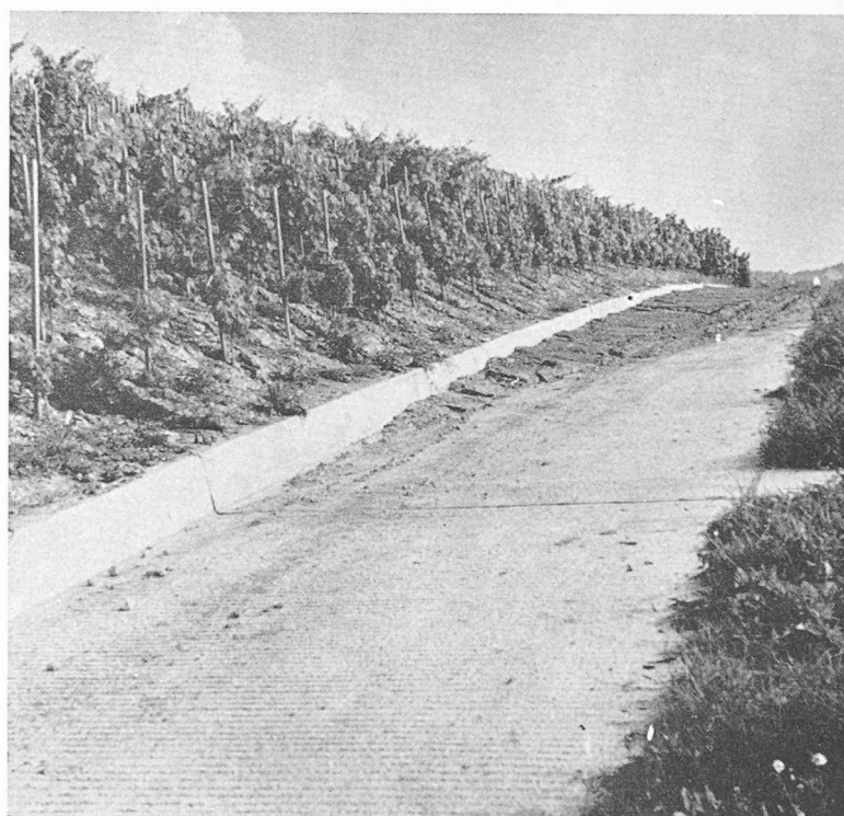
Fig. 8. — Route viticole : terres sédimentées sur la dalle au cours d'un orage.
