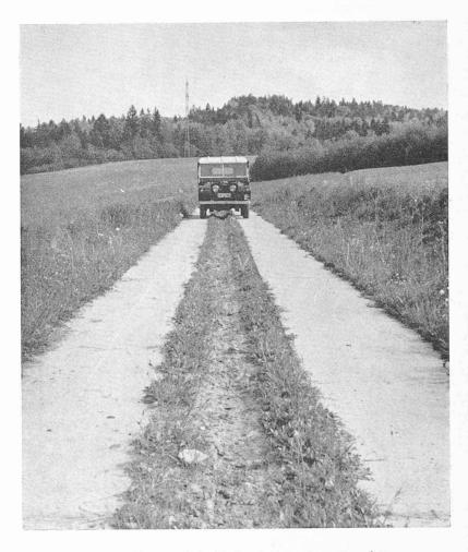
Fig. 10. — Chaussée à double bande de roulement, en béton.
