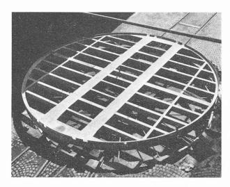
Fig. 27. — Charpente de plaque tournante.
