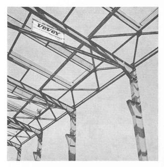
Fig. 8. — Vue d'une travée de la halle Sécheron, de 23,50 m de portée.
