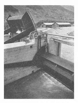
Fig. 19. — Vannes-secteurs sur le Rhône au barrage de Gluringen (Haut-Valais).
