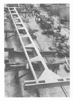
Fig. 20. — Pont roulant pour la CIPAG, à Vevey. Ce pont fonctionne actuellement dans la halle de la figure 4. Photo Vevey n° 4010.
