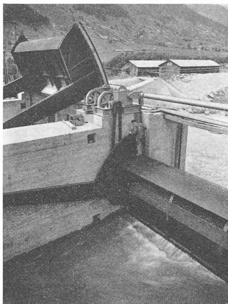
Fig. 19. — Vannes-secteurs sur le Rhône au barrage de Gluringen (Haut-Valais).
