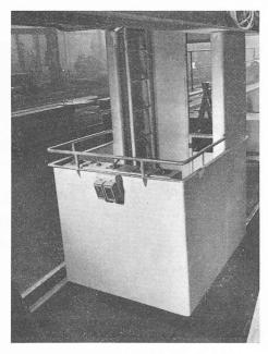
Fig. 21. — Cabine de pont roulant traitée à la manière d'une carrosserie. Photo Vevey nº 3872.
