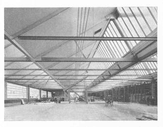
Fig. 14. — Fabrique de Produits Firestone, Pratteln. Nouvel agrandissement sans colonnes intermédiaires. Ingénieur: H. Bargetzi, dipl. E.P.F., Bâle. Photo Vevey nº 4022.
