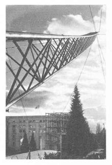
Fig. 25. — Hissage du mât d'un derrick de montage. Photo Vevey nº 2684.
