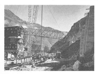
Fig. 24. — Chantier pour un grand barrage en haute montagne. Montage d'une passerelle entre silos à ballast et tour à béton.
