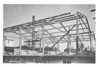
Fig. 7. — Halle double pour les Ateliers de Sécheron, à Genève. Vue d'ensemble pendant le montage. Architecte : L. Payot, dipl. E.P.F., Genève.
