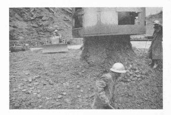
Fig. 2. — Décharge d'une benne de 6 m³ de béton, en tas.  $\Lambda$  l'arrière-plan : bulldozer-épandeur.
