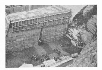
Fig. 7. — Simplicité et efficacité: permettent la mise en place de 8000 m³ de béton en une journée de travail.
