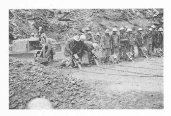
Fig. 3. — Bulldozer-épandeur en action. La pervibration est laissée « dans les mains de manœuvres ».
