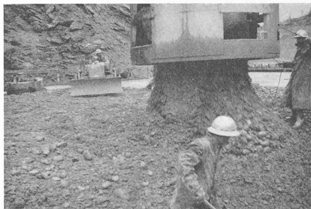
Fig. 2. — Décharge d'une benne de 6 m 3 de béton, en tas. A l'arrière-plan : bulldozer-épandeur.
