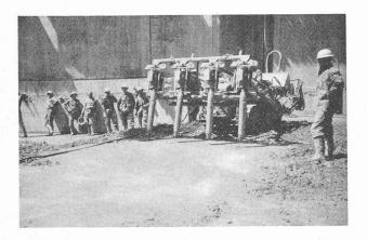
Fig. 5. — L'introduction de pervibrateurs montés sur tracteur spécial.
