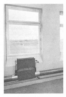
Fig. 11. — Appareils « Velovent » en cours de montage. La conduite d'air primaire est déjà en place.
