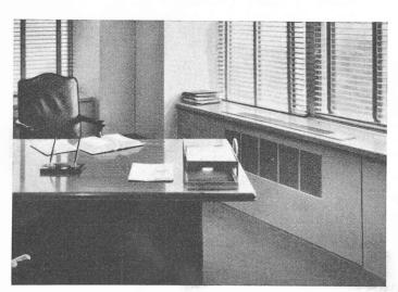
Fig. 5. — Bureau équipé de climat-convecteurs, système Carrier
