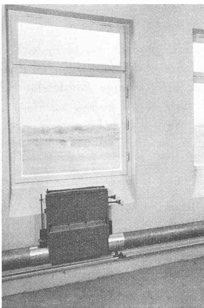
Fig. 11. — Appareils « Velovent » en cours de montage. La conduite d'air primaire est déjà en place.
