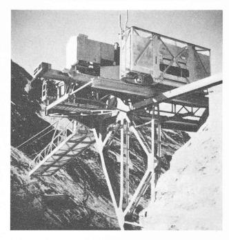
Fig. 5. — Pont 1 de Mauvoisin avec le chariot d'ancrage.
