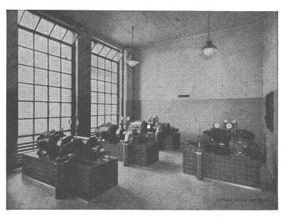
5 compresseurs «ROTASCO» pour la réfrigération les entrepôts frigorifiques
