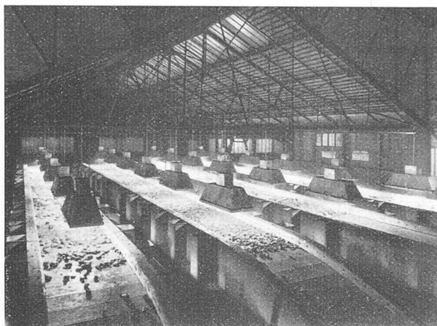
Fig. 4. — Installation pour le triage du charbon. Lampes à vapeur de mercure (haute pression) sous réflecteurs.
