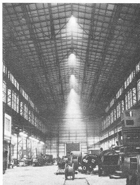
Fig. 5. — Eclairage d'un grand hall par lampes à ballon fluorescent sous réflecteurs profonds.
