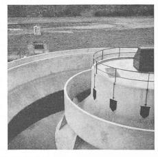
Fig. 2. — Remplissage d'un des Aéro-Accélérator d'Elbeuf. Remarquer les ouvertures (fermées actuellement) et le manchon cylindrique.
