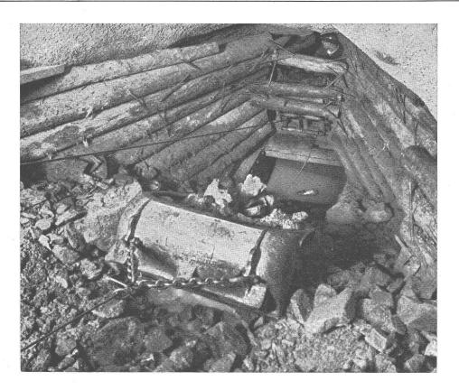
Treuil de raclage à deux tambours JOY avec moteur à air comprimé de 25 CV et racloir JOY AMSCO en acier à haute teneur de manganèse en service au puits incliné du Consortium Lot 6, Schindler & Schmalz (Forces Motrices de la Gougra).
