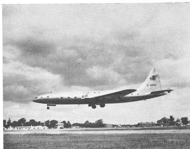
Le Brabazon , tentative hardie entre toutes : quatre hélices coaxiales contrarotatives absorbent la puissance de quatre groupes de turbopropulseurs Proteus jumelés de 6400 ch par groupe (à l'arrêt, altitude 0 m, plus 715 kg de poussée), logés dans l'aile (soit 25.600 ch ) ( \varnothing hélice = 4,88 m).
