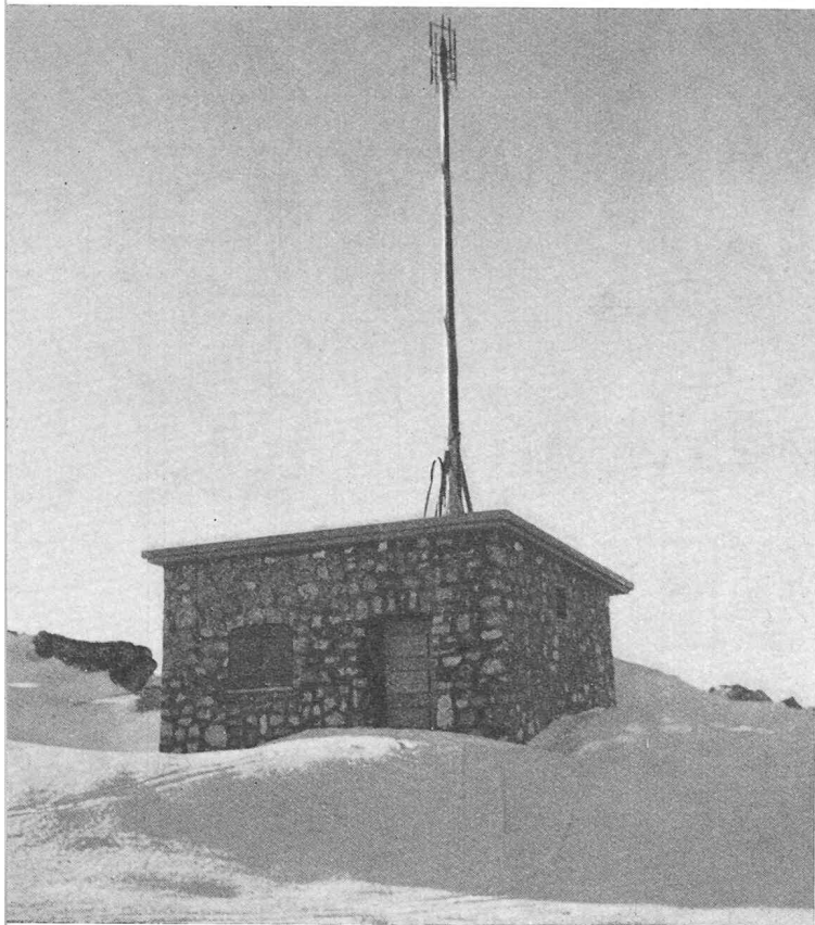
Un radiogoniomètre automatique, installé à la Dôle, indique au contrôleur des voies aériennes, la direction des avions avec lesquels il est en contact.
