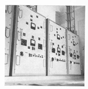
Les émetteurs à ondes ultra-courtes installés à la Dôle pour les liaisons du contrôle régional et du service d'information en vol avec les avions en route.
