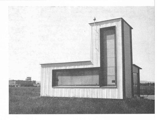
Radar d'approche de précision. Derrière les deux fenêtres oblongues sont placés les systèmes d'antennes qui balaient l'espace dans la direction de l'approche, l'une (horizontale) en azimut, l'autre (verticale) en élévation.
