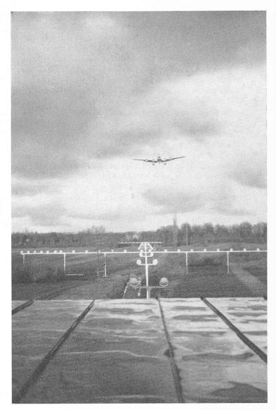
Une partie des lampes de la ligne de feux à haute intensité qui marque les 900 derniers mètres de l'approche avant la piste.
