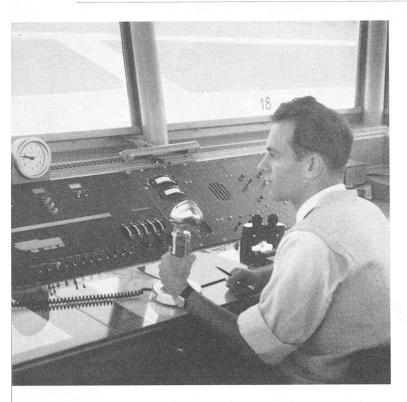
Le contrôle d'aérodrome avec le tableau de commande des divers balisages lumineux, les commandes d'alarme et, outils par excellence de tous les contrôleurs, la montre et le microphone.
