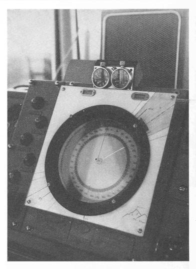
Détail de l'écran du radiogoniomètre automatique. La trace lumineuse sur 46 degrés indique la direction de l'avion qui émet.
