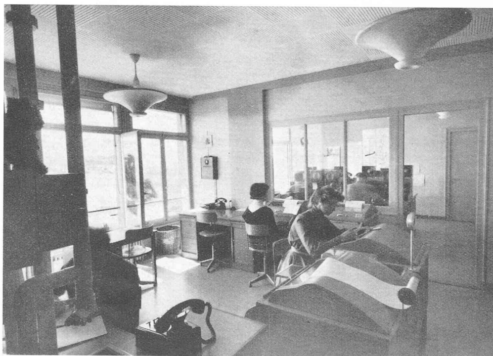
Communications. C'est de là que partent et que sont reçus tous les messages tels que plans de vol, départs, arrivées, retards, etc. Au fond, la salle des liaisons radiotéléphoniques et radiotélégraphiques à moyennes et grandes distances avec les avions en vol.
