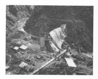
Fig. 9. — Vue générale du chantier du barrage. (Février 1955.) A gauche : batardeau amont ouvert pour la mise en cau.
