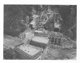
Fig. 5. — Vue générale de la rive droite. A droite : partie inférieure de la prise d'eau et entrée de la galerie d'amenée. (Avril 1954).
