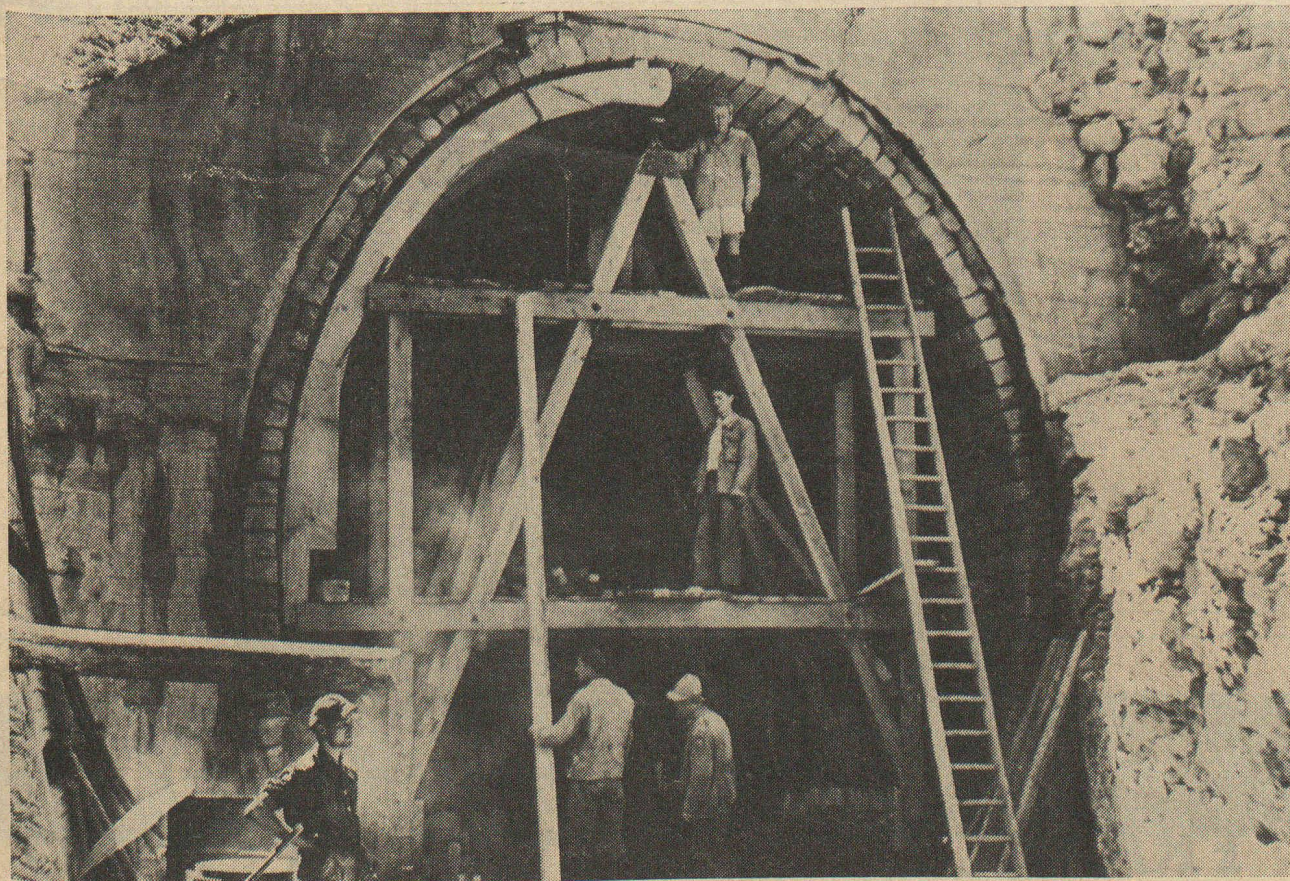
Etanchéité d'une galerie contre les eaux souterraines exécutée en OPPANOL BA-Folie Hirschy & Co S. A., 50, rue de Lausanne, Genève
