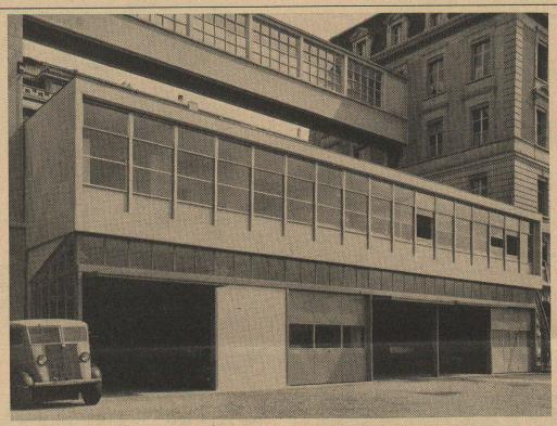
Eléments de vitrages en métal léger pour façades Système à doubles guillotines s'ouvrant simultanément
