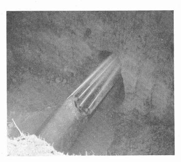
Fig. 10. - Forage à jet d'eau à haute pression.
