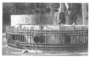
Fig. 2. - Segment de puits avec tubes de guidage.
