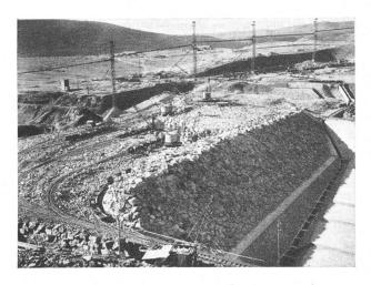
Fig. 54. — Vue du parement aval en construction.
