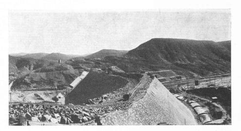
Fig. 55. — Vue du parement amont en construction.
