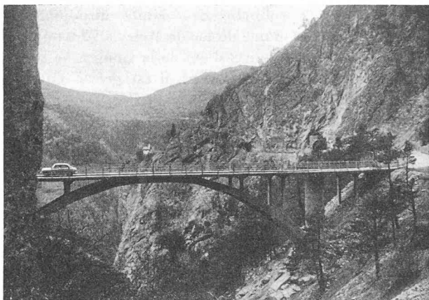
Fig. 9. — Route Sierre-Vissoie. Pont des Pontis (projet A. Sarrasin). Au fond à droite : portail du nouveau tunnel ; à gauche de ce dernier : portail de l'ancien tunnel. (Photo Automobil Revue)
