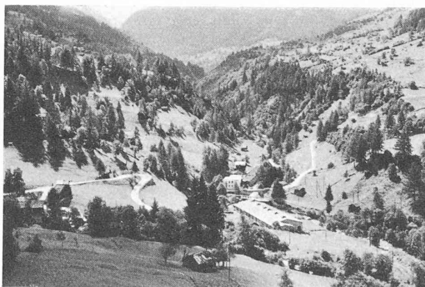
Fig. 7. — Usine actuelle des Services industriels de la commune de Sierre et station actuelle de dessablage du palier Vissoie-Chippis de la S. A. pour l'Industrie de l'Aluminium. Emplacement de la nouvelle usine de Vissoie. (Photo AIAG)
