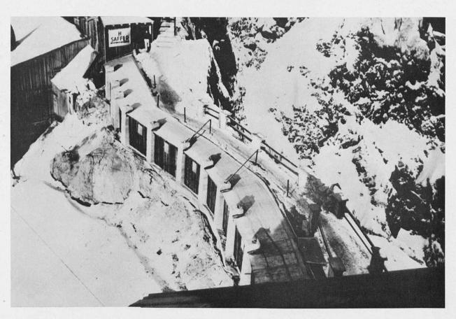
Etanchéité en « RUWANOL ST » exécutée sur galerie, en haute altitude.
