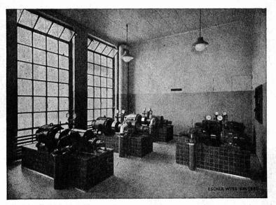
5 compresseurs «ROTASCO» pour la réfrigération les entrepôts frigorifiques
