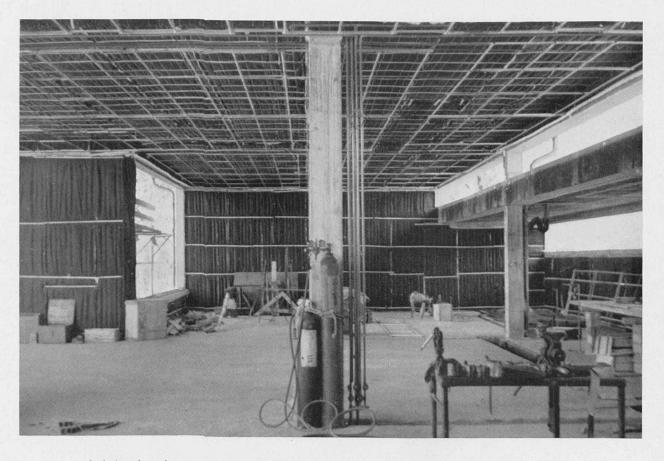
Isolation thermique par matelas VETROFLEX des murs et plafonds au Collège de La Sallaz.
