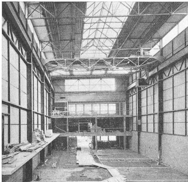
Fig. 5. — Vue partielle de la halle III.
