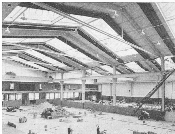
Fig. 1. — Halles I et II en exécution.
