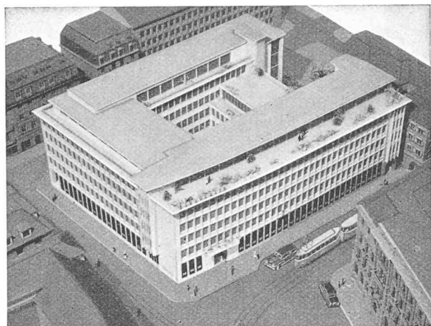
Fig. 4. — Nouveau bâtiment d'une importante banque de Zurich traité par climatisations « Jettair » et conventionnelles.
