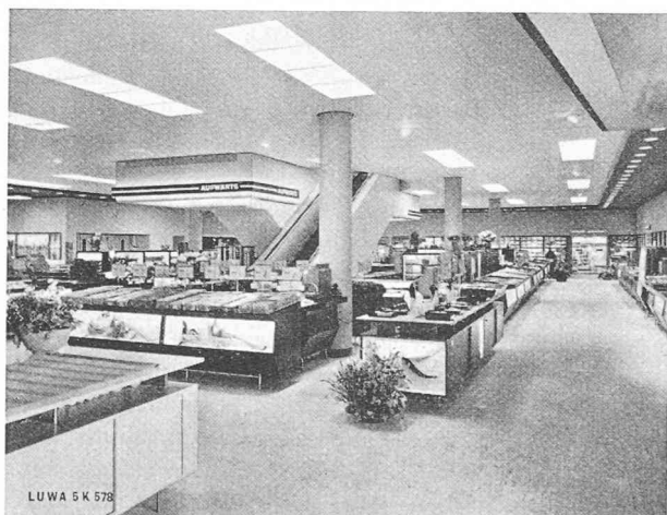
Fig. 2. — Etage de vente de grand magasin avec double plafond perforé pour pulsion d'air conditionné.
