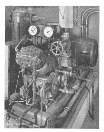
Fig. 3. — Un des deux compresseurs frigorifiques de 75 CV à ammoniaque pour climatiser le grand magasin de la figure 1.
