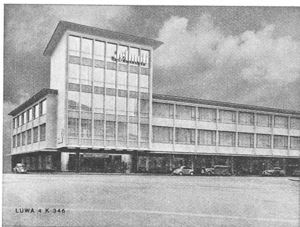
Fig. 1. — Nouveau bâtiment d'un grand magasin traité par climatisations conventionnelles.
