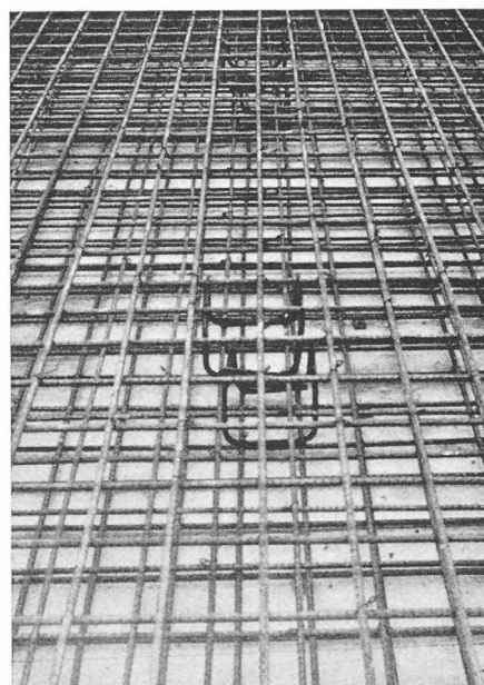
Fig. 3. — Armature de la dalle inférieure. On remarque le décalage des trois nappes.
