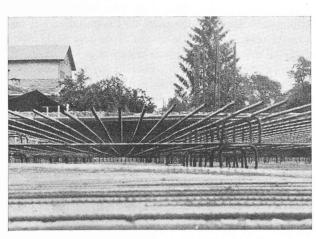
Fig. 2. — Armature de la dalle inférieure. On remarque les trois nappes superposées.
