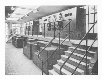
Fig. 4. — Convertisseurs à contacts pour une installation d'électrolyse,  $4 \times 10~000~\mathrm{A}$  sous une tension continue de  $350~\mathrm{V}$ .
