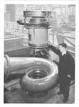
Fig. 6. — Bâche spirale de la Forme III avec roue et tambour du frein, en montage.
