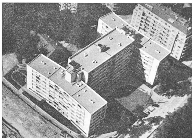
Fig. 7. — Ventilateurs individuels de l'immeuble « Malagnou-Parc ».
