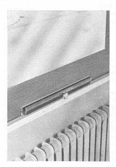
Fig. 3. — Soupape d'air frais montée dans le cadre d'une fenêtre,
