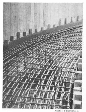
Fig. 7. — Corps intermédiaire — Armature d'une rampe.
