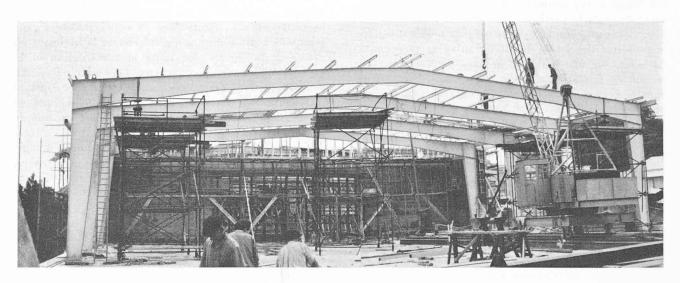
Fig. 2. — Pavillons sud — Montage de la charpente métallique.
