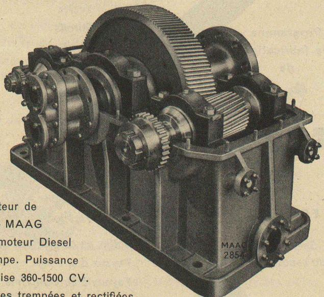
Réducteur de vitesse MAAG entre moteur Diesel et pompe. Puissance transmise 360-1500 CV.
